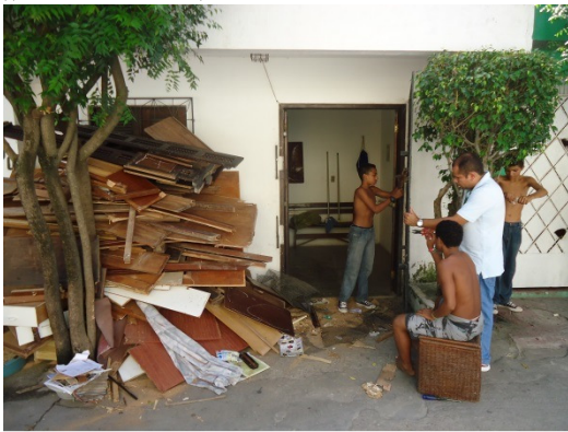
Matheus und seine Kollegen bei der Renovierungsarbeit.
